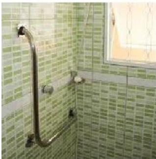
**Barra de apoio em "L"**, fabricada em aço inox, com acabamento polido. O diâmetro mínimo deve ser de 3cm, usualmente encontrada com 3,175cm ou 1 1/2 polegadas. Utilizadas para apoio de pessoas com deficiência e idosos, são fixadas nas paredes de banheiros. Devem suportar carga mínima de 1,5kN ou 152,96kg.
