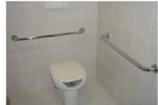
**Barra de apoio** reta, fabricada em alumínio, com acabamento em pintura epoxi prata ou branca. O diâmetro mínimo deve ser de 3cm, usualmente encontrada com 3,175cm ou 1 1/2 polegadas. Utilizadas para apoio de pessoas com deficiência e idosos, são fixadas nas paredes de banheiros. Devem suportar carga mínima de 1,5kN ou 152,96kg.
